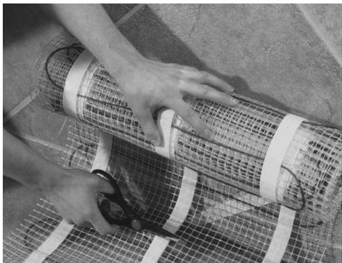
Нагревательный мат, включая место присоединения к «холодному» кабелю должен полностью быть покрыт выравнивающим составом или клеем.
