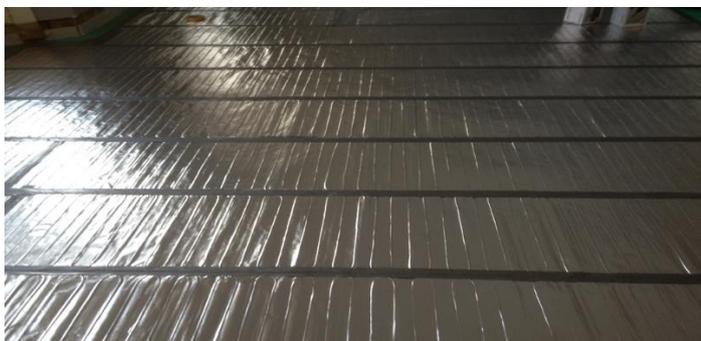
Рис. 10) Завершенная установка нагревательных матов AluMat
