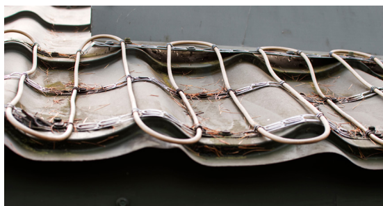
34000003 – Auf der Dachfläche verschraubt
