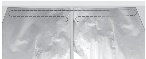
Abb. 6. Matte ausrollen, Folie abschneiden und umdrehen
