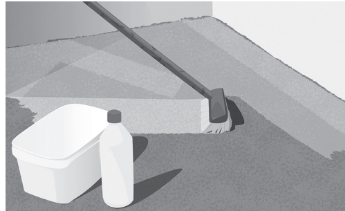
Рис. 3. Очистка и обработка пола
