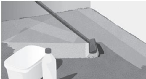
Рис. 3. Очистка и грунтование пола
