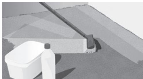
Joonis 4. Põranda puhastamine ja kruntimine
