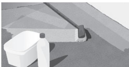
Рис. 4. Очистка и грунтование пола
